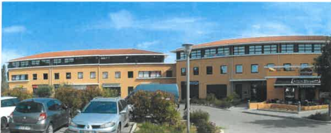
Commerces situés au Nord-Ouest de la RD9
