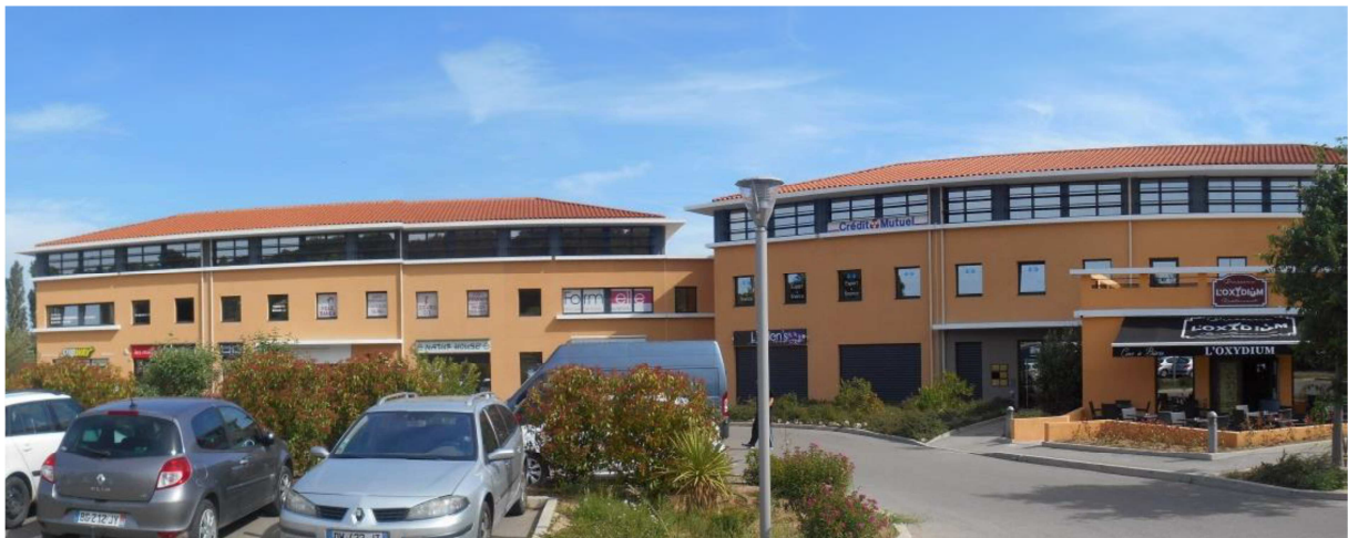
Commerces situés au Nord-Ouest de la RD9
