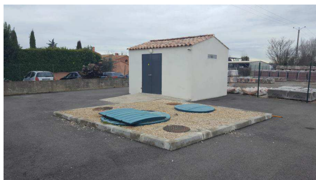
Vue extérieure du poste de relevage
