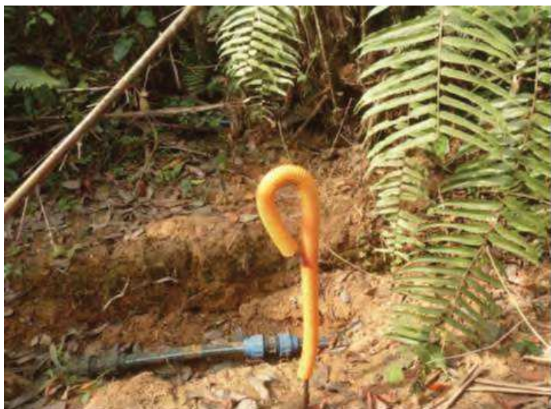
Identification et marquage des raccords enterrés
