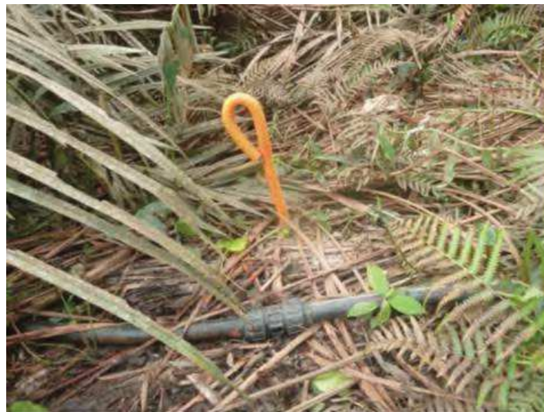
Identification et marquage des raccords enterrés
