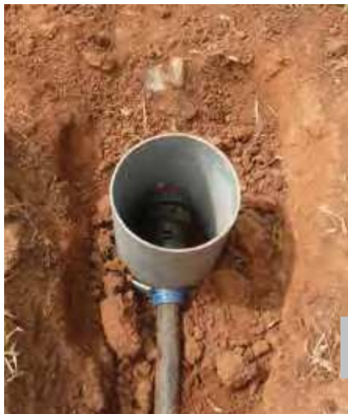
Protection des vannes réseaux
