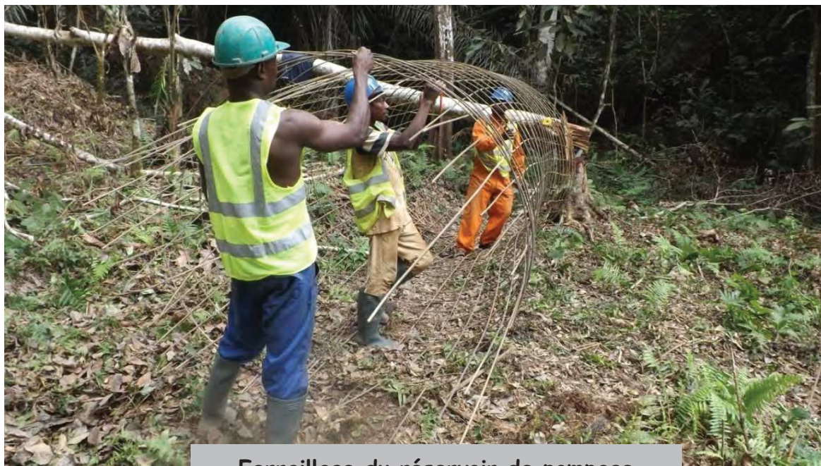
Ferrailage du réservoir de pompage
