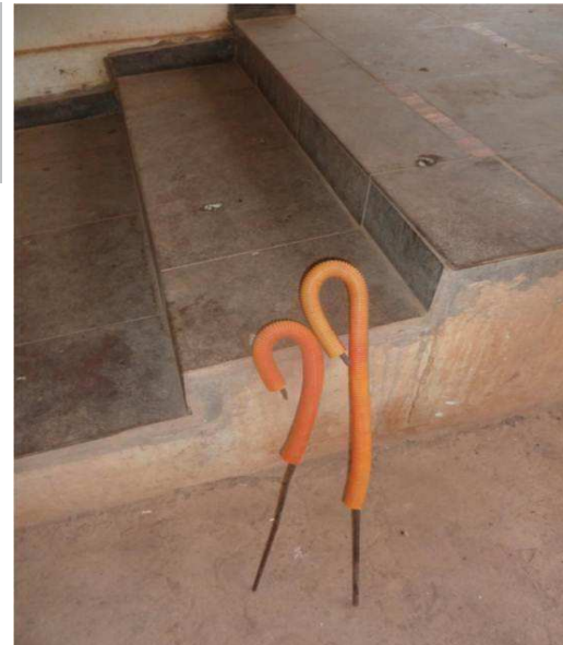
Identification et marquage des raccords enterrés
