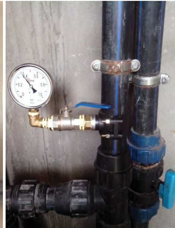
Installation d'un manomètre pour lecture du niveau de l'eau dans le réservoir de stockage
