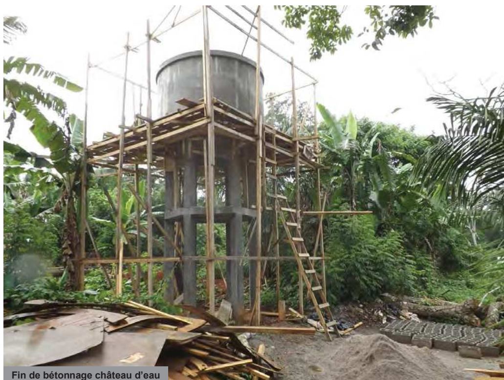
Ferrailage du réservoir de stockage
