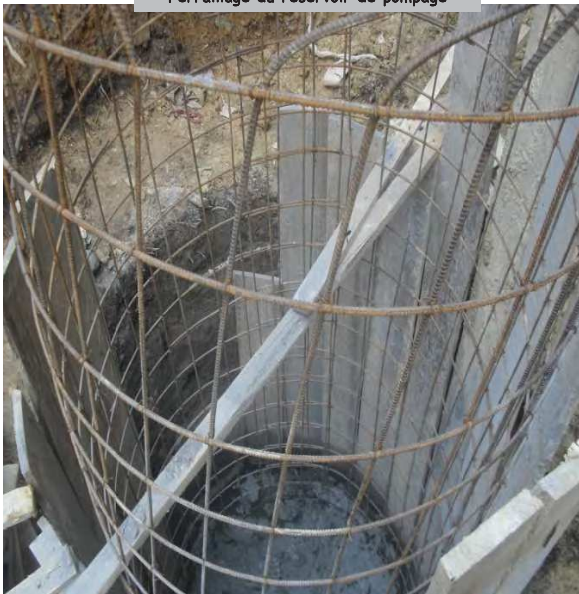
Ferrailage du réservoir de pompage
