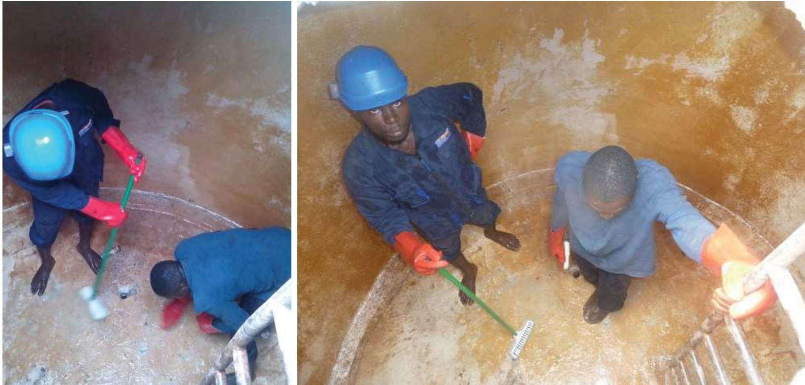
Brossage désinfection par injection de d'eau de Javel surdosée selon protocole SES puis rinçage de l'ensemble réservoir de stockage et réseau total
