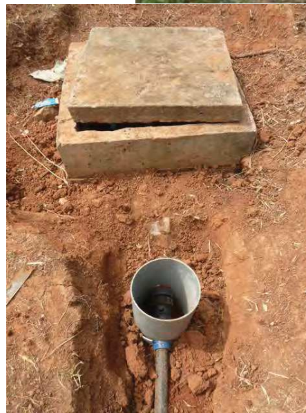
Protection des vannes réseaux
