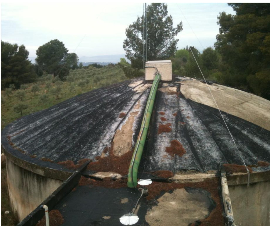
réservoir avant travaux
