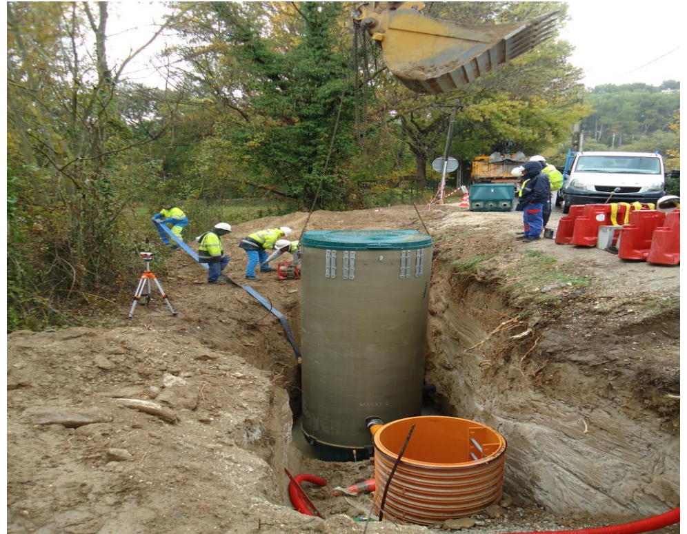
Pose de la station de refoulement Diamètre 1200 - hauteur 3,75 m
