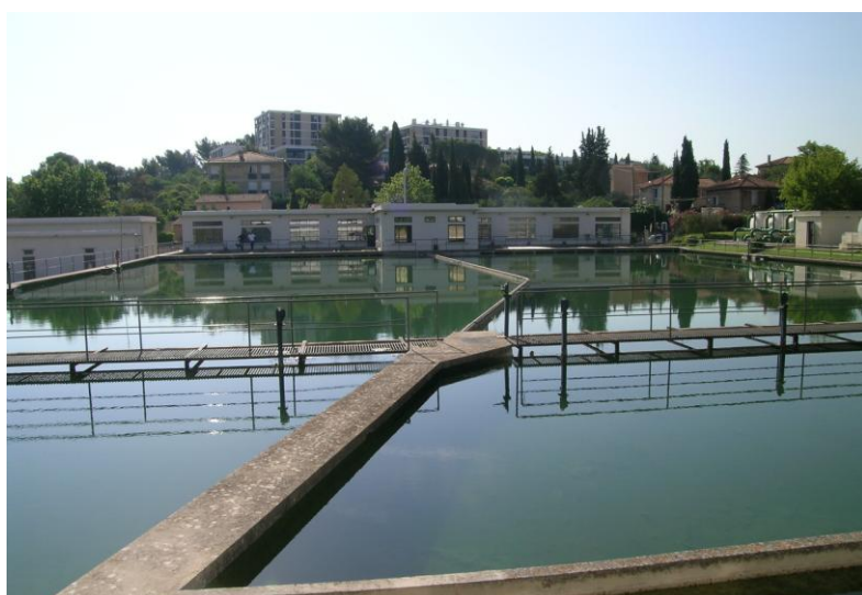
Bassins de décantation de Saint Eutrope
