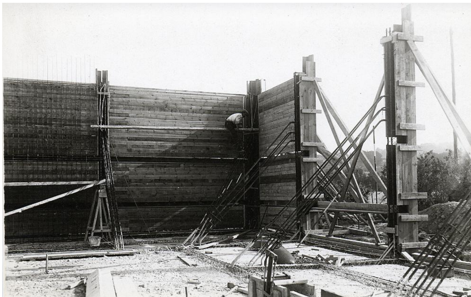
Construction du réservoir de Saint Eutrope
