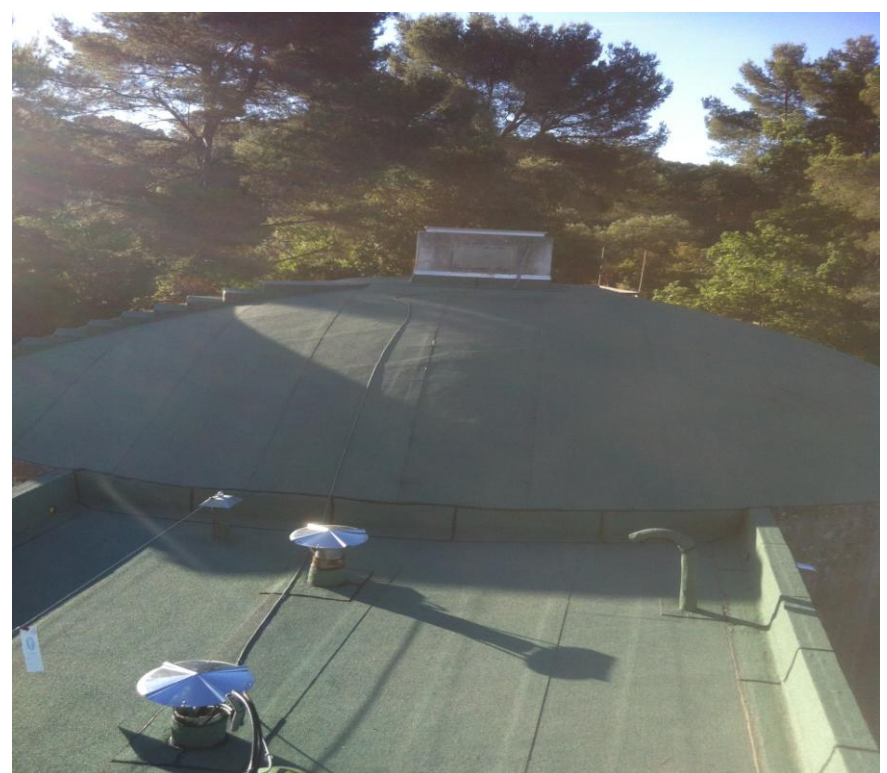
réservoir après travaux
