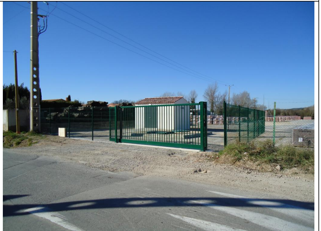
Photo fin de travaux – Ouvrage réceptionné
