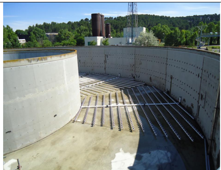
Diffuseur d'air après travaux
