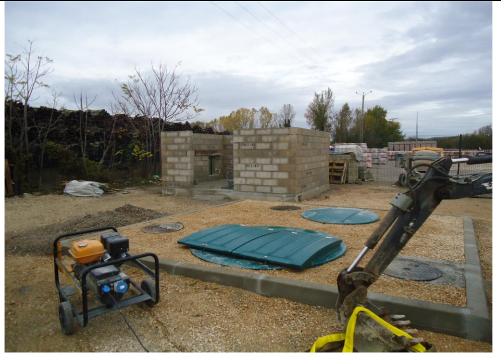
Photo en cours de travaux – Remblaiement du PR
