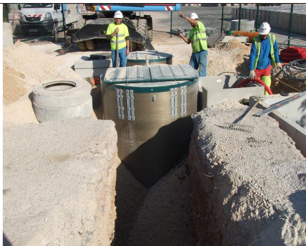
Photo en cours de travaux – Pose du poste de refoulement
