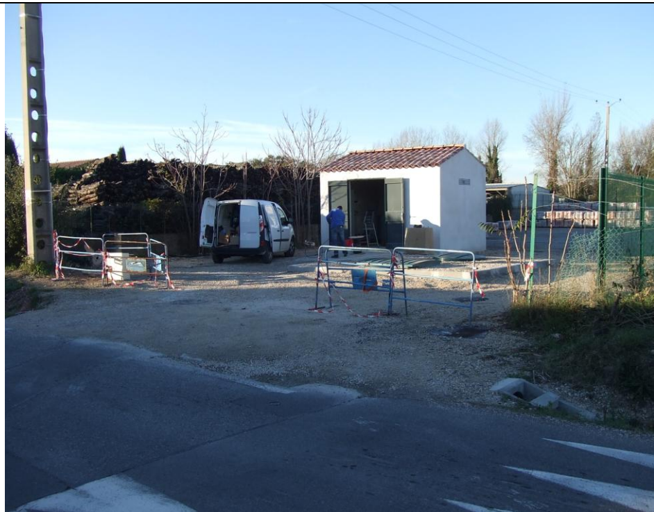
Photo en cours de travaux – Montage des équipements électriques et groupe électrogène
