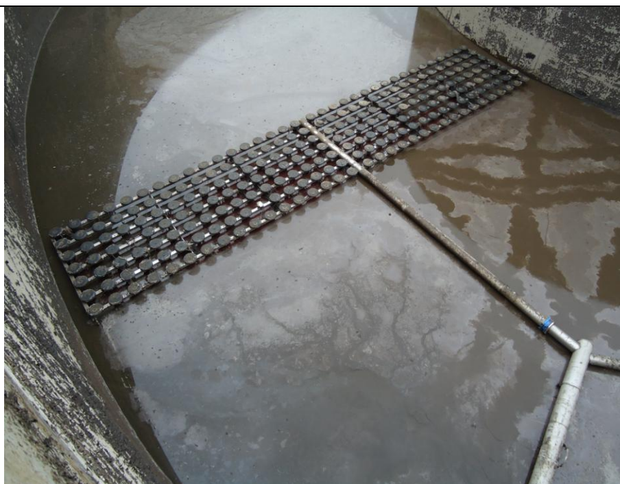
Diffuseur d'air avant travaux
