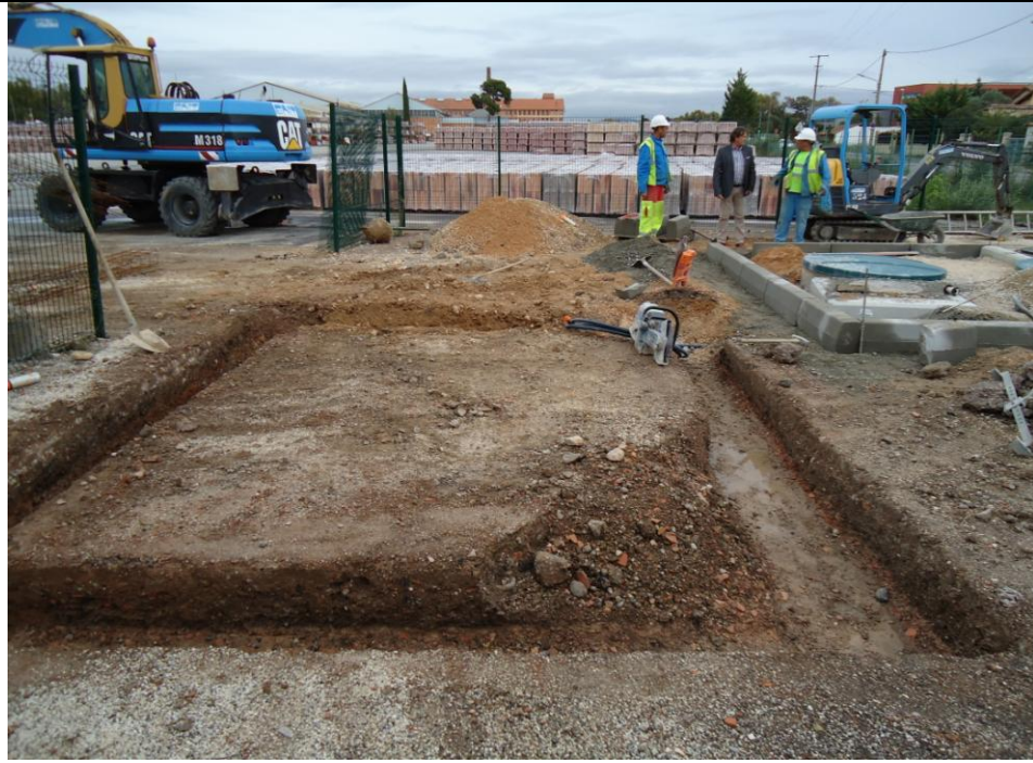
Photo en cours de travaux – Terrassement du bâtiment technique
