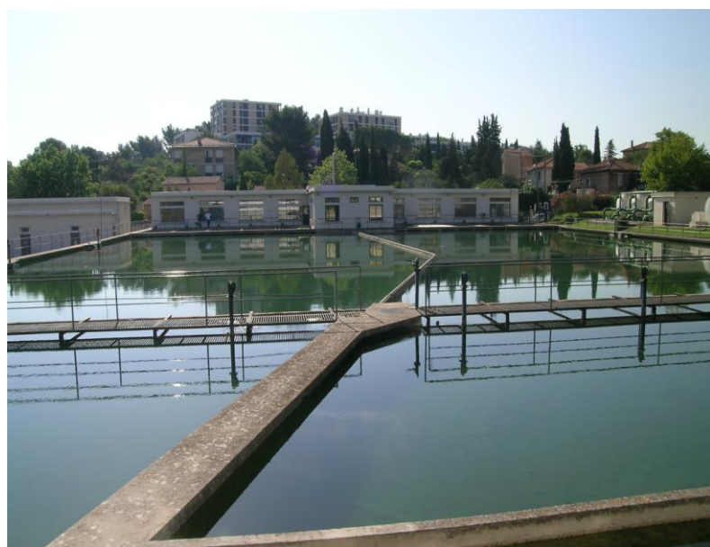
Bassins de décantation de Saint Eutrope
