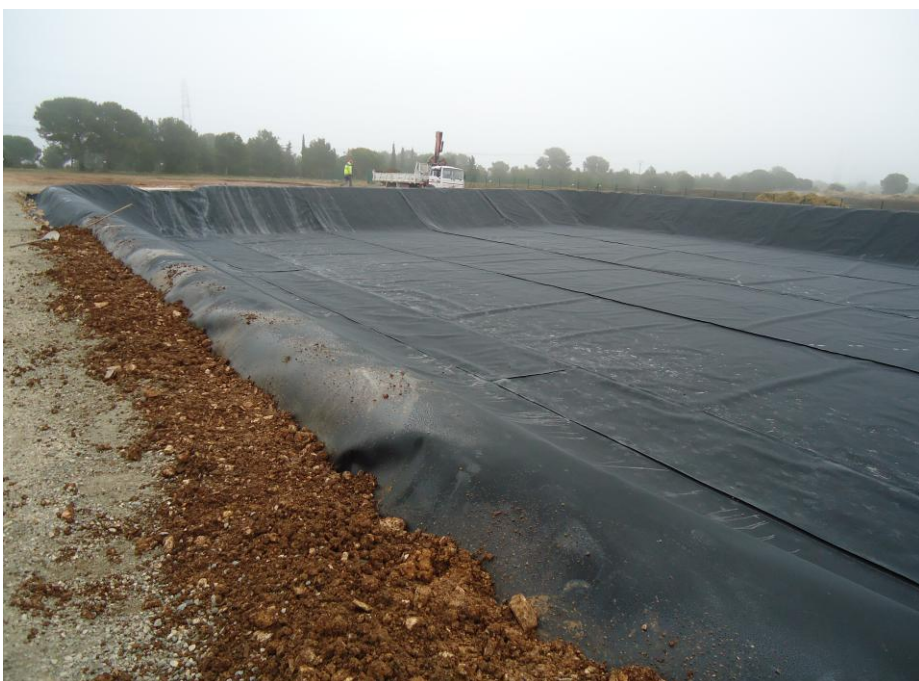
Pose de l'étanchéité du bassin de confinement
