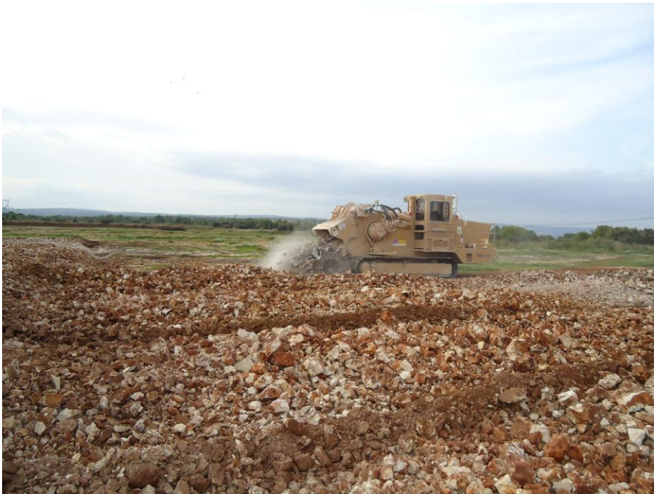
Terrassement de la plateforme
