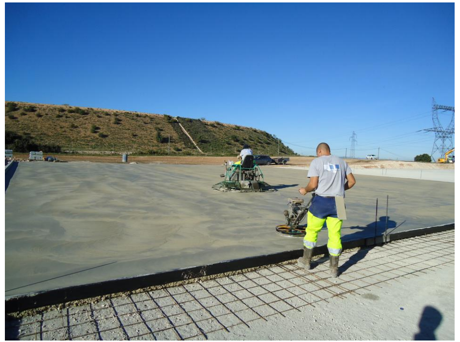
Pose et lissage du béton d'étanchéité
