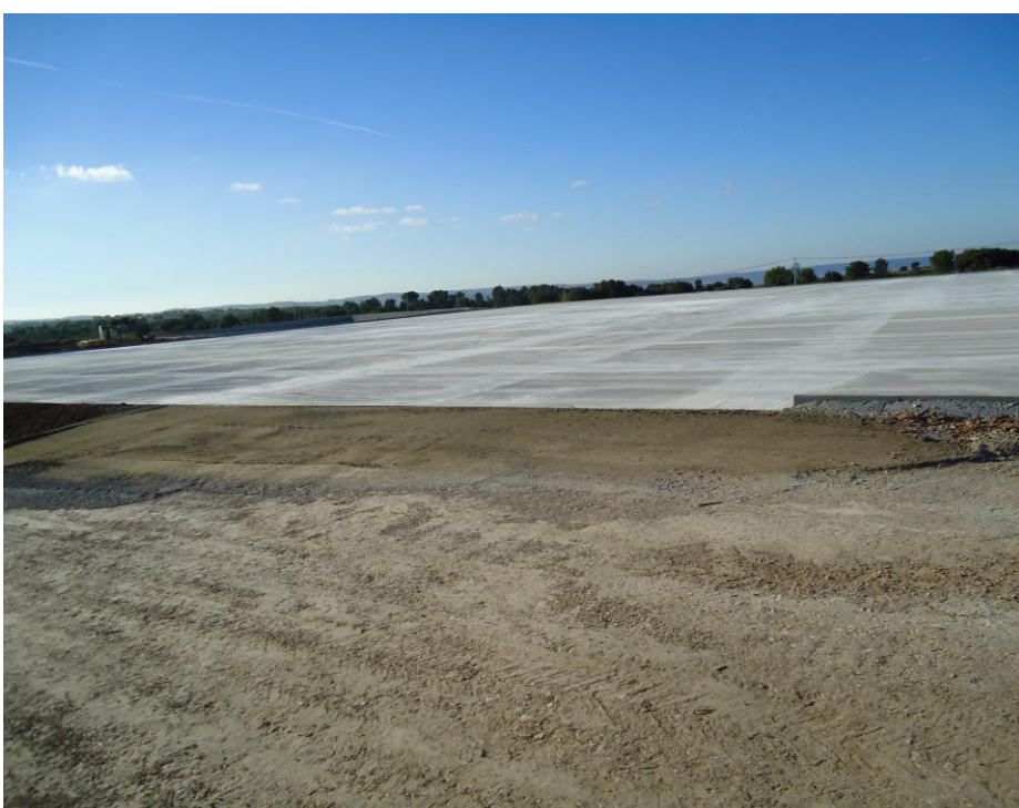
Vue de la plateforme achevée
