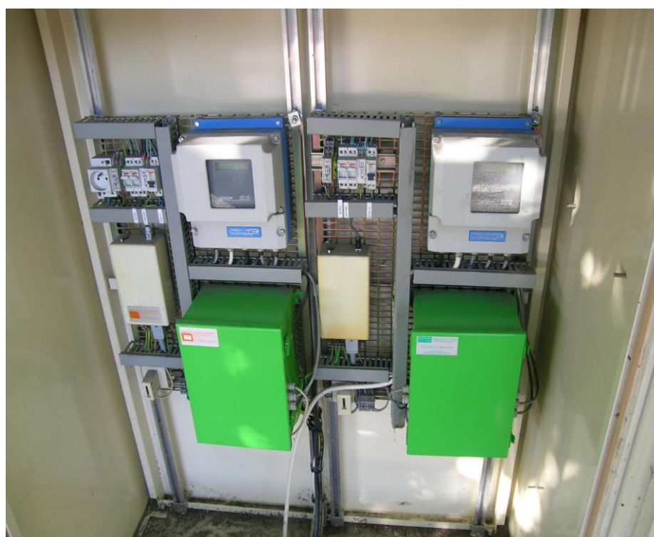
Armoire de commande débitmétrie
