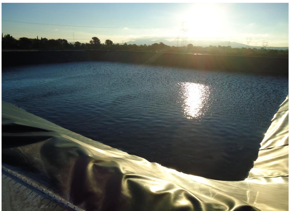
Bassin de confinement terminé
