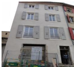
Place Mirabeau Pertuis Réhabilitation d'un immeuble
