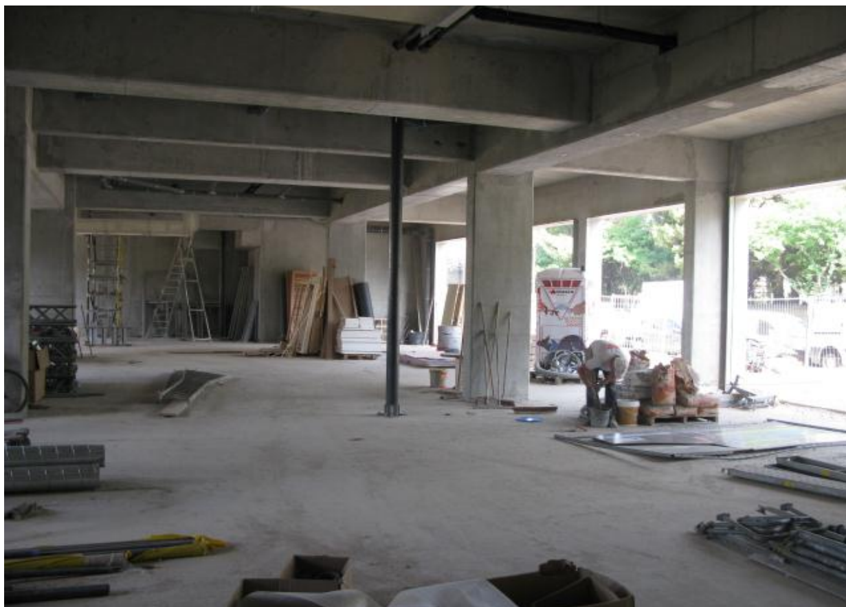
Figure 4 Vue intérieure du local, avant fermeture des ouvrants
