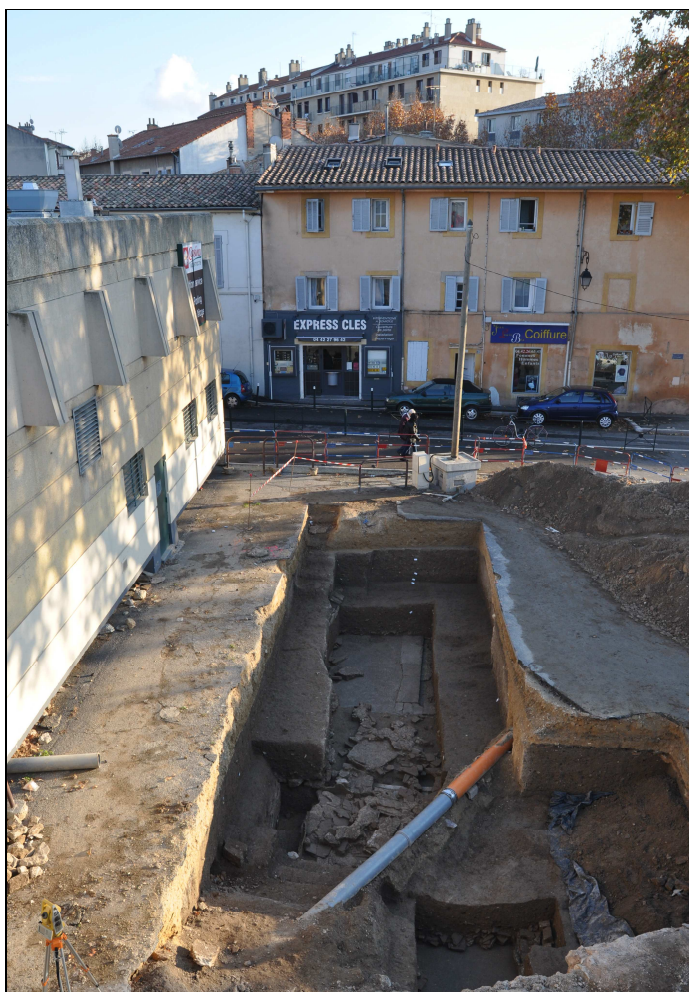
Supermarché Casino, 1, av. Maréchal-de-Lattre-de-Tassigny : tranchée de diagnostic, nov. 2011
