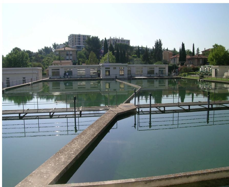
Figure 4: Bassins de décantation de Saint Eutrope
