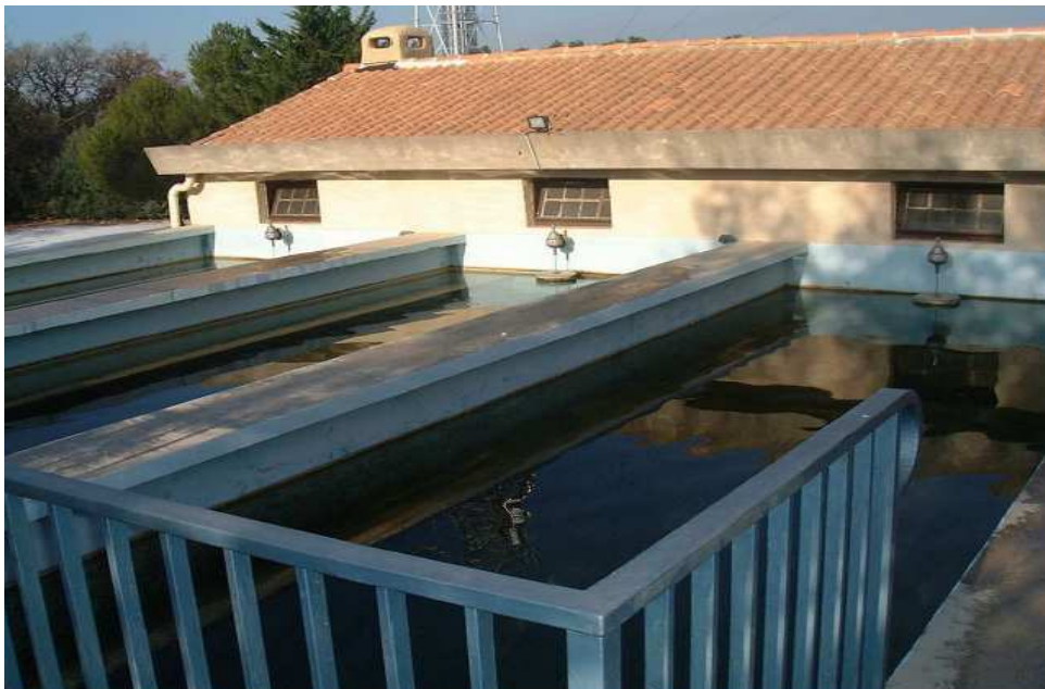
Figure 3: Vue générale de l'usine du Puy du Roy
