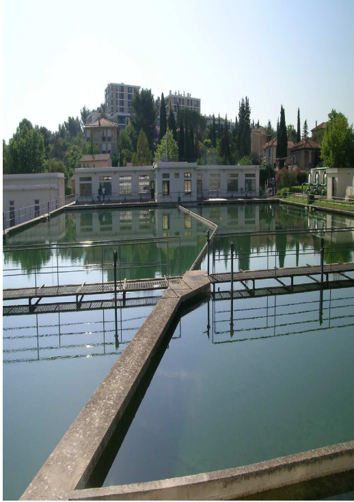
Figure 4: Bassins de décantation de Saint Eutrope
