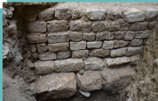
Fig. 25. Rue Monclar. Façade de l'aile sud, où se trouvait le logis des Gouverneurs. Photo Leïa Dubois.
