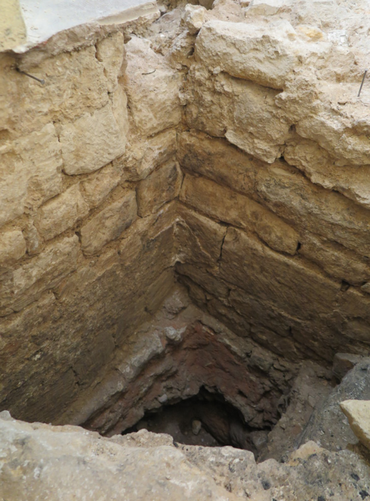
Fig. 15. Parement du mur gouttereau nord (à droite), chaîné à la maçonnerie du corps de bâtiments de l'aile orientale du cloître (à gauche). Photo C. Auburtin.
