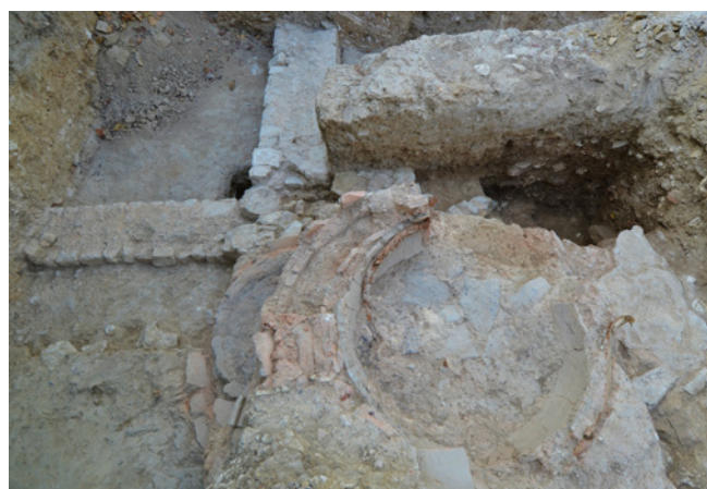
Fig. 4. Réseau de chaleur, résidence de Hanoï. Le four circulaire et de son alandier (en contrebas, sur la gauche). La sole est constituée de gros fragments de dolium . Photo L. Dubois.
