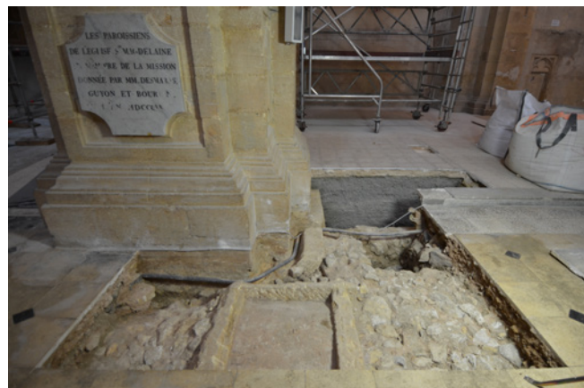
Fig. 16. Caveau maçonné sous le sol de la nef. Au second-plan, pilier d'Époque moderne (1691-1703) établi sur le dérasement du mur gouttereau sud de l'église médiévale. Photo C. Auburtin.
