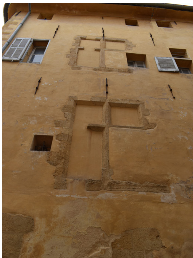
Fig. 22. 10, rue Mignet, hôtel de Gassier. État de la façade nord, percée de deux grandes fenêtres à croisée et d'une multitude d'autres ouvertures. Photo Claire Auburtin.
