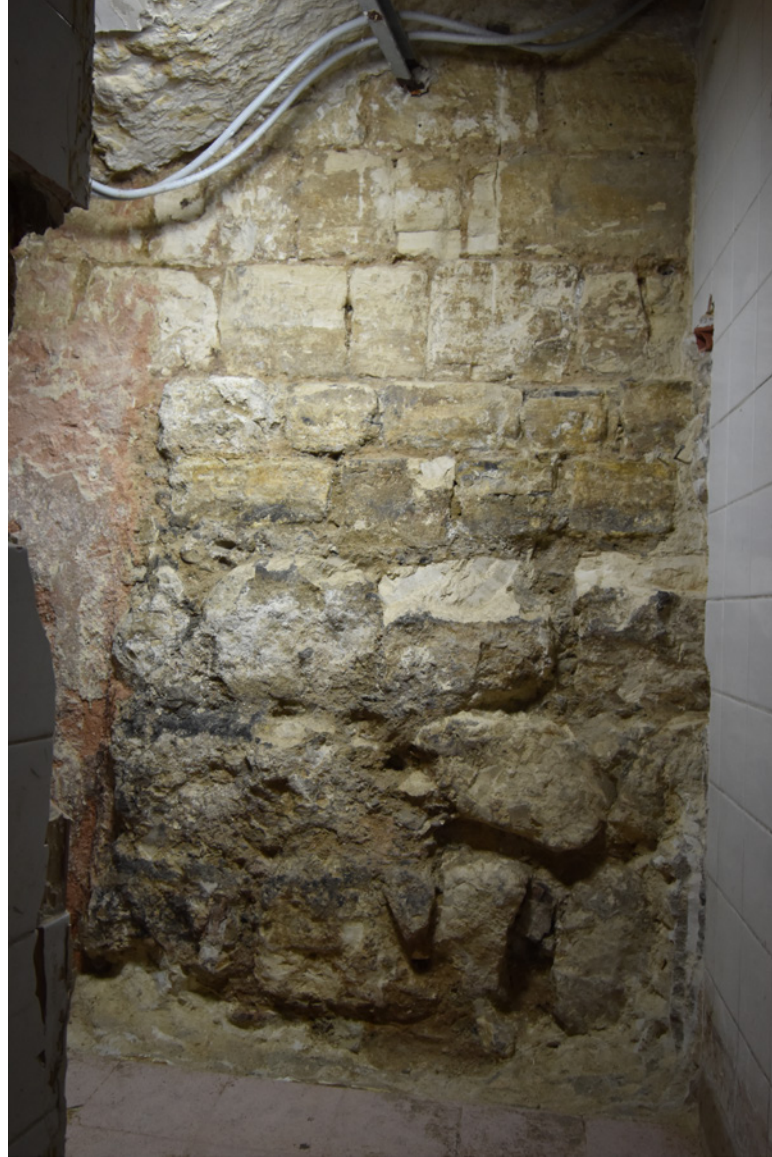
Fig. 16. 1, rue Portalis. Fondation et amorce de l'élévation de la chapelle médiévale conservées dans la cave de l'habitation.
