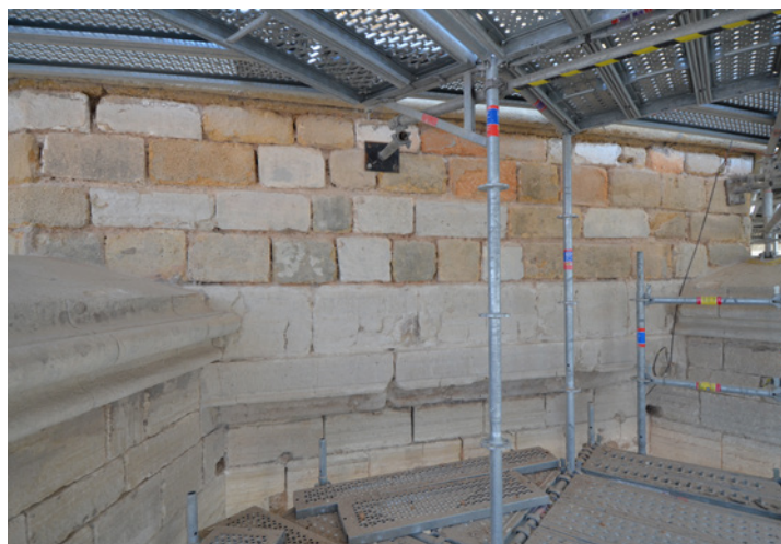
Fig. 9. Cathédrale Saint-Sauveur. Couronnement en encorbellement de la cinquième travée du chevet. Les cinq assises supérieures correspondent au rehaussement des toitures au début du XVIII e s.
