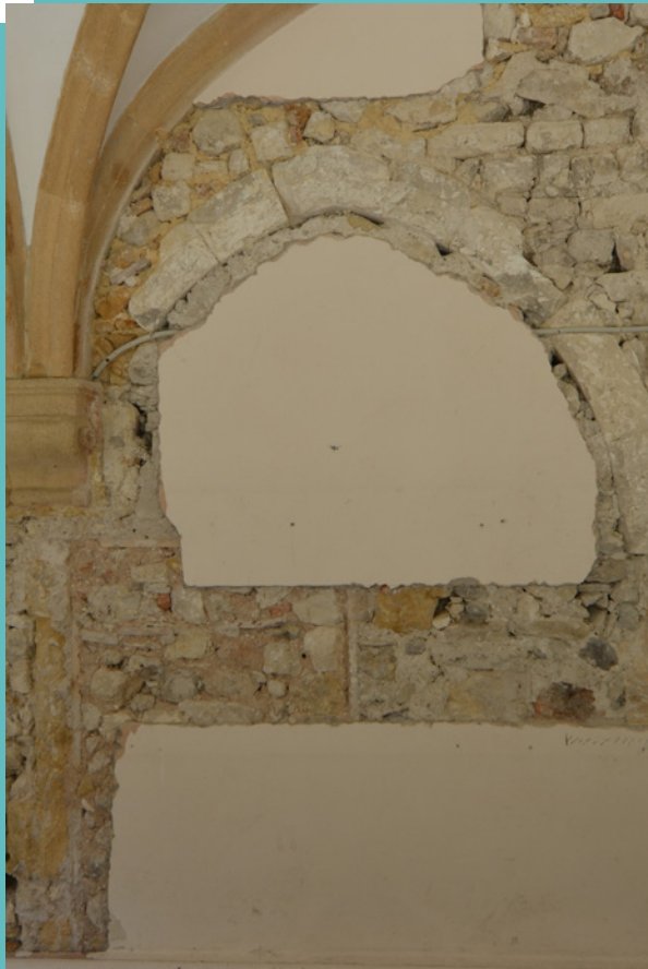
Fig. 11. Collège des Prêcheurs. Cloître, galerie nord. Enfeu révélé par le décaottage des revêtements.
