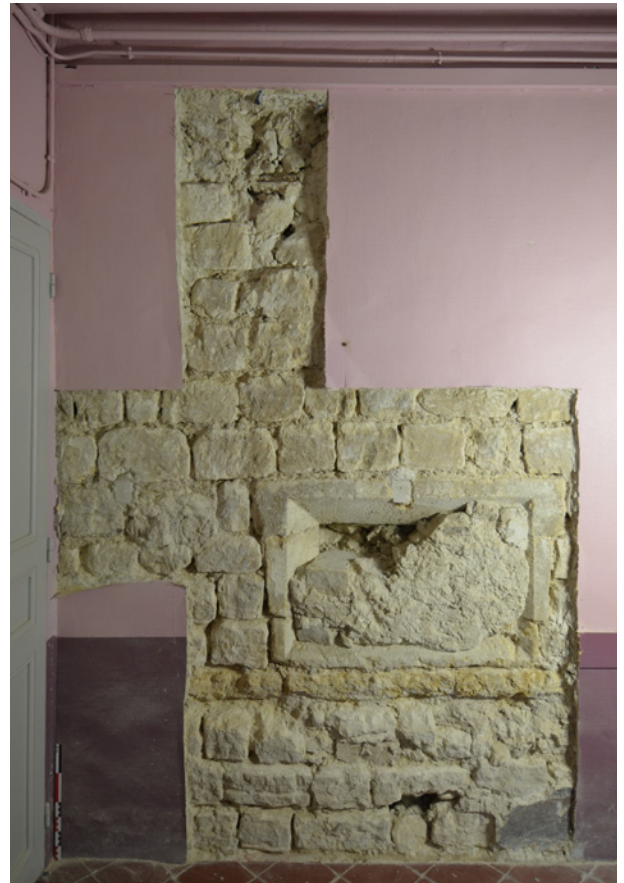
Fig. 12. Collège des Prêcheurs. Cloître, galerie haute. Vue d'une baie ancienne à encadrement de pierre.
