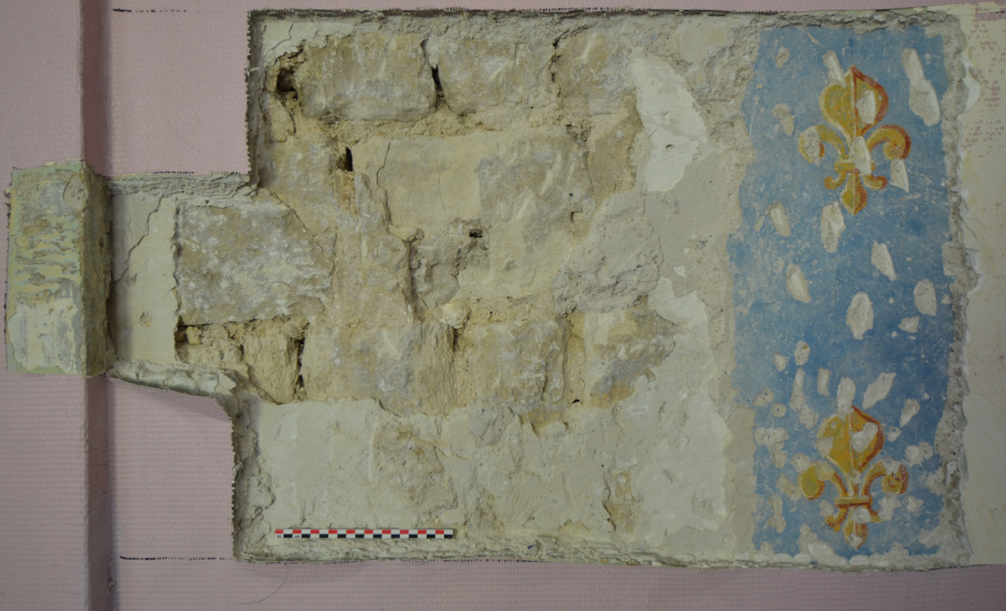
Fig. 13. Collège des Prêcheurs. Cloître, galerie haute. Détail d'un enduit peint avec décor de fleur de lys.
