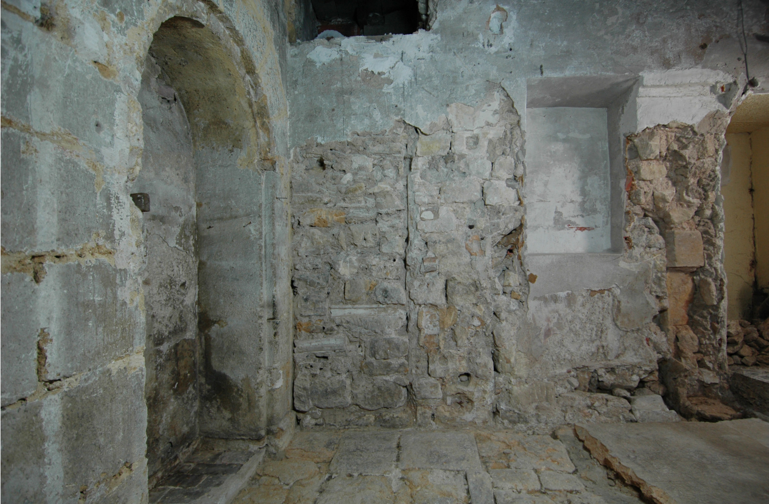
7ter, rue Mignet. À gauche, porte mettant en communication la nef nord de l'église et le chœur des dominicaines. Période moderne.
