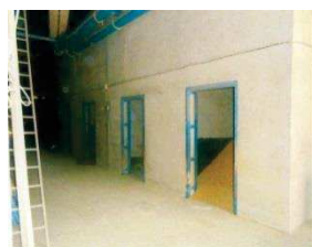
Photo 2 : Bâtiment d'exploitation Silos de stockage
