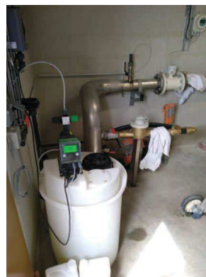
4 - Post chloration + comptage de sortie
