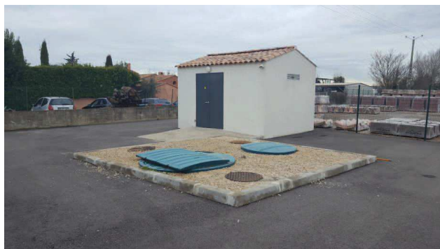
Vue extérieure du poste de relevage
