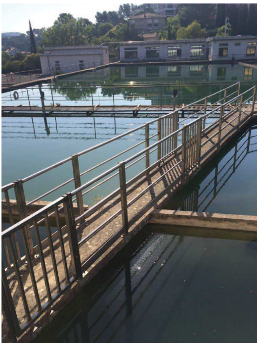
Bassins de décantation de Saint Eutrope
